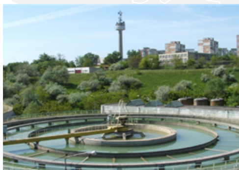
Uzina de apă nr 2-Decantor (foto3)
