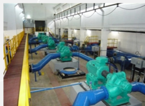
Uzina de apă nr.2- Sala pompelor (foto 2)
