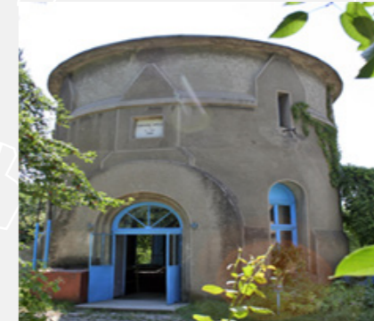
SCADA Turnul de apă (foto 8)
