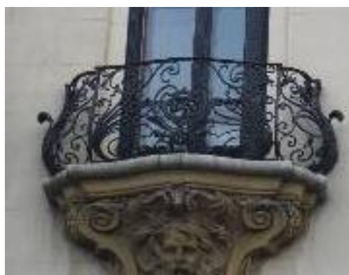
Figură 27: detaliu balcon fier forjat restaurat, Palatul Cantacuzino, București
