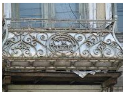
Figură 26: detaliu balcon fier forjat Strada Traian, Galați
