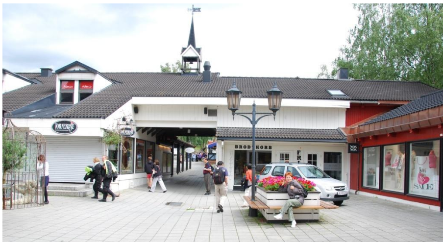
Figură 14: Lillehammer, intervenție modernă cu sugerarea materialelor tradiționale la acoperiș
