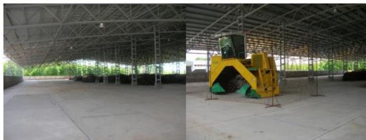
Stația de compostare Galați
