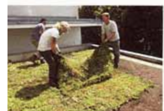
> Acoperiș extensiv: montarea "covorului verde"
