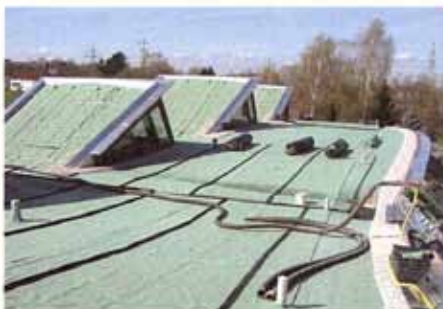
2 - Punerea stratului de protecție, drenaj și filtrare, a canalului de drenaj, a sistemului anti-alunecare
