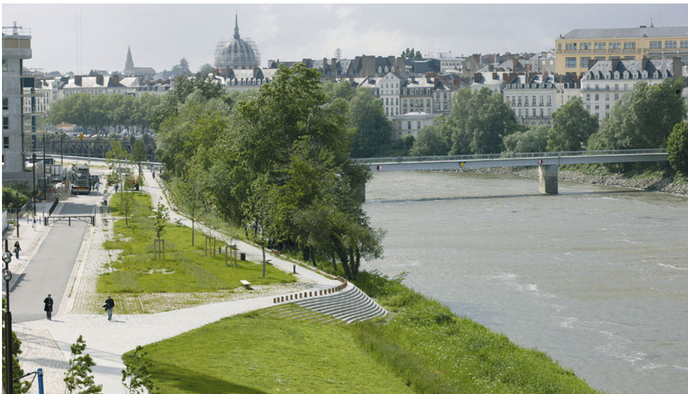
> Malurile Loarei la Nantes, alternanța de spații împădurite și de deschideri; zonele din apropierea circulațiilor sunt tunse de două ori pe an.
